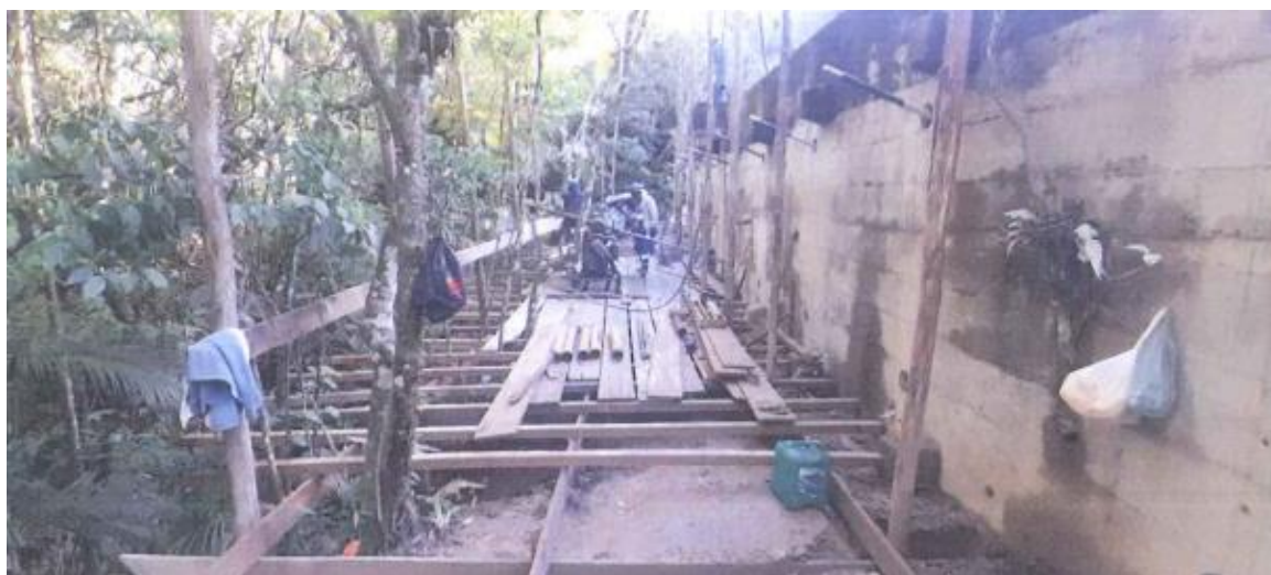
Figura 6.23 Rota 116 – Reforço no muro de contenção – Km 63+000 Norte
