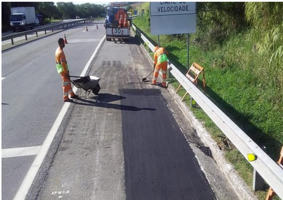
Figura 6.2 Via Lagos – Recuperação superficial de acostamento – Km 20+000 Norte
