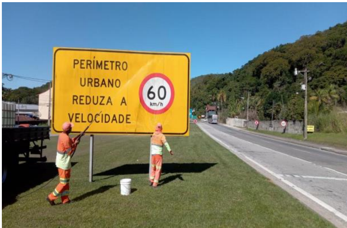
Figura 6.4 Via Lagos – Limpeza de placa – Km 0+700 Norte
