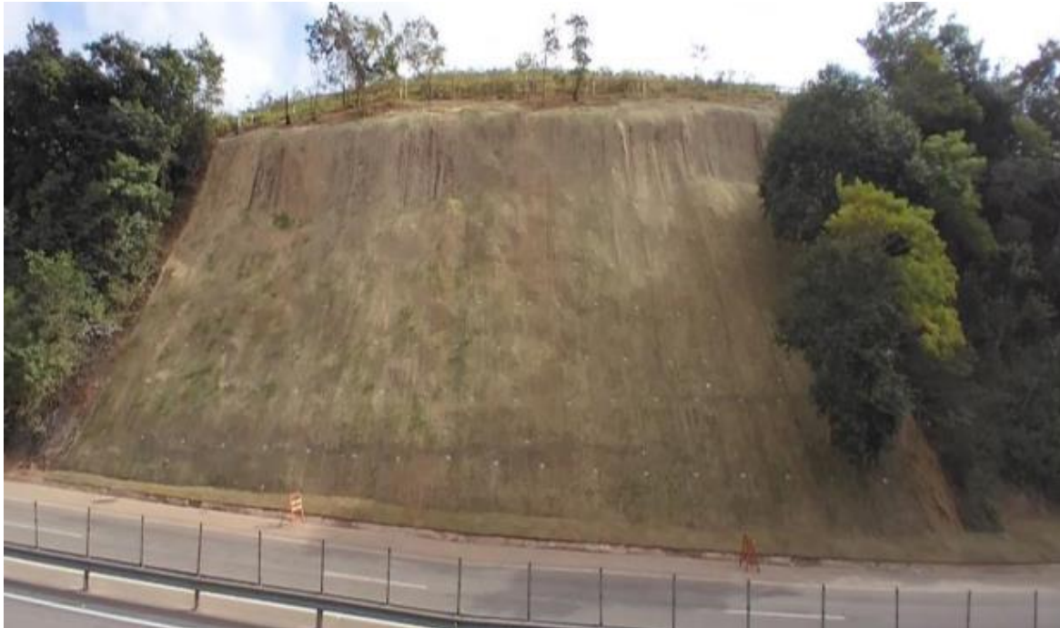
Figura 6.13 Via Lagos – Talude de corte – Km 19+300 Sul
