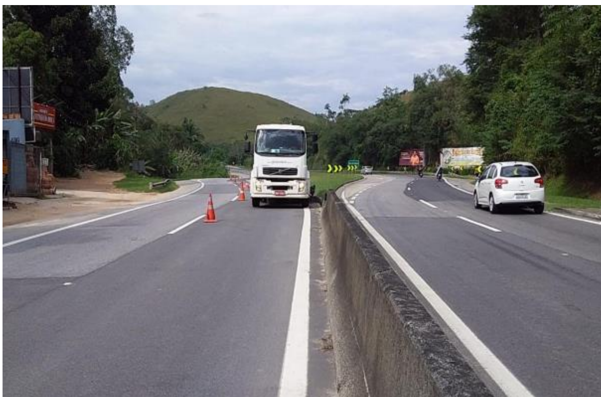
Figura 6.10 Via Lagos – Varrição de mediana – Km 2+000 Sul
