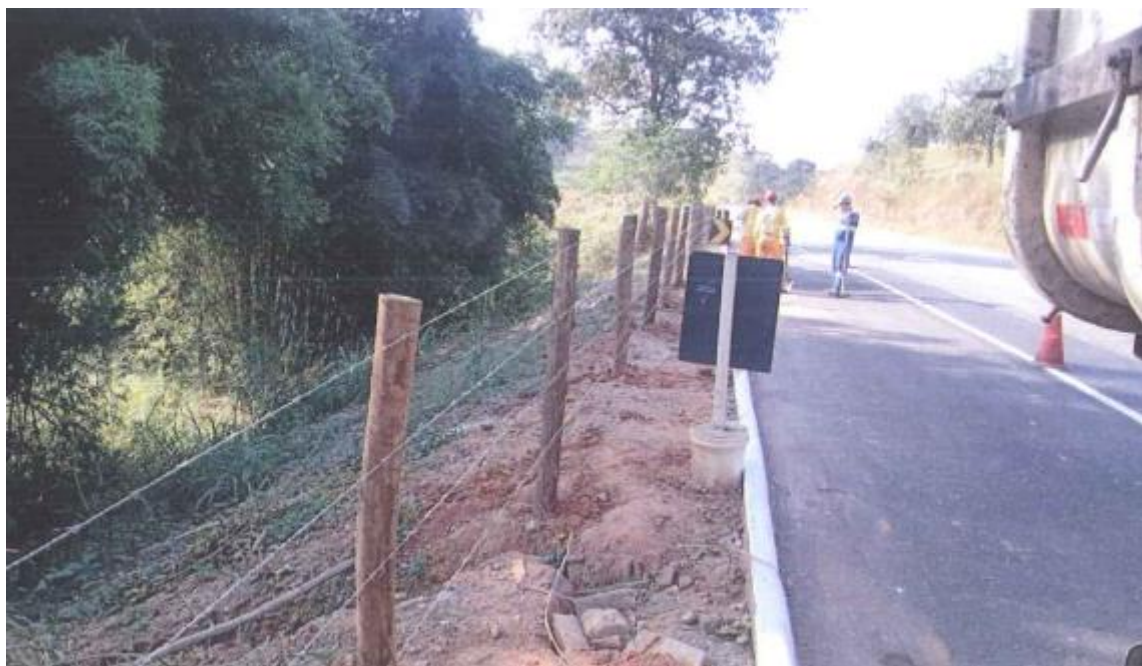
Figura 6.25 Rota 116 – Reconstrução de cerca – Km 129+000 Sul
