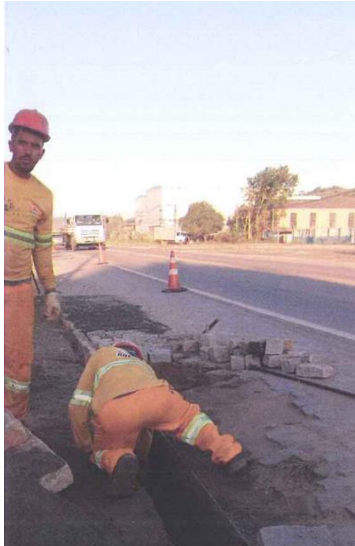
Figura 6.21 Rota 116 – Limpeza de drenagem– RJ-104
