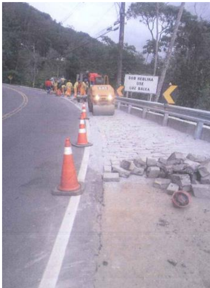
Figura 6.22 Rota 116 – Obra emergencial de contenção – Km 67+800 Sul
