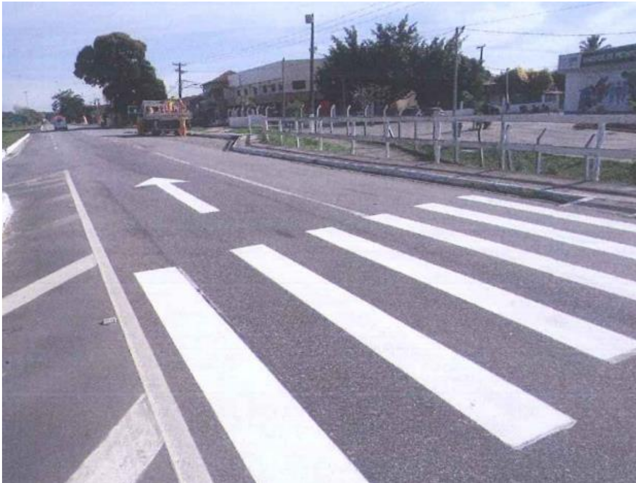
Figura 6.19 Rota 116 – Pintura de faixa de pedestre – Km 21+300
