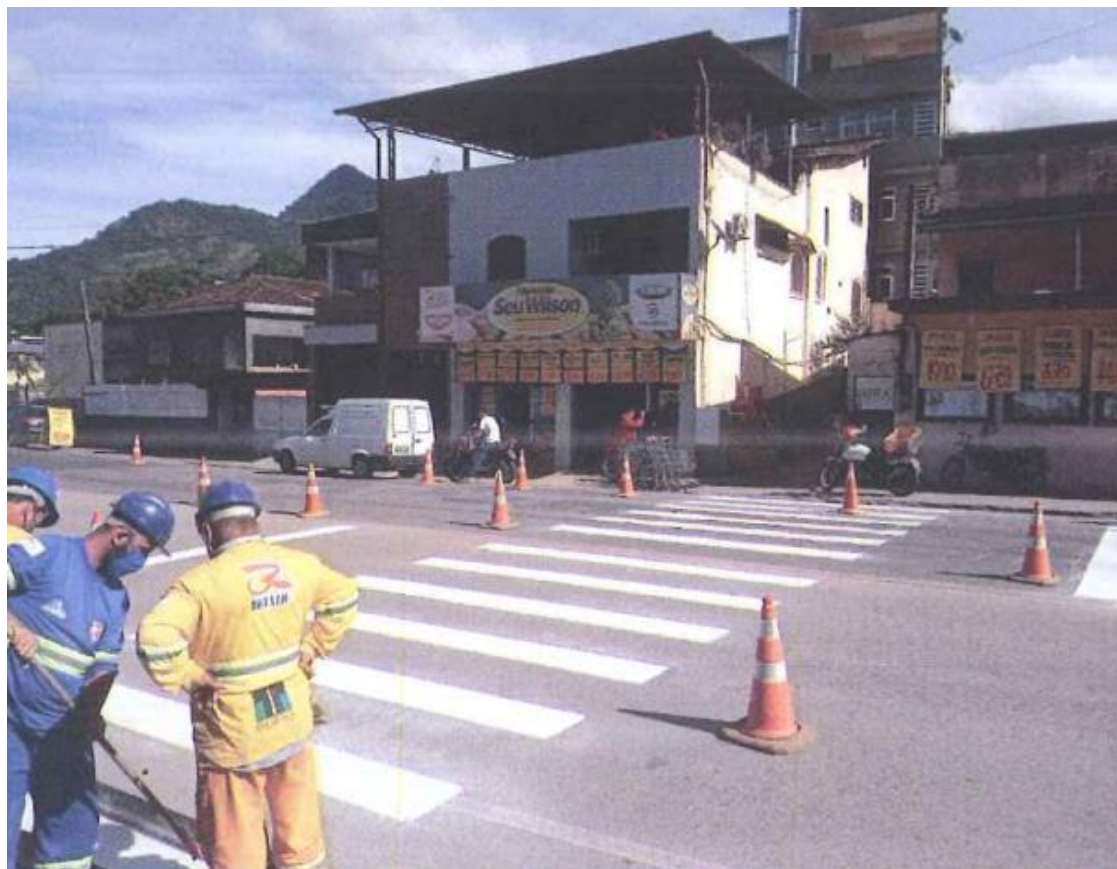
Figura 6.20 Rota 116 – Pintura de faixa de pedestre – Km 41 ao 42
