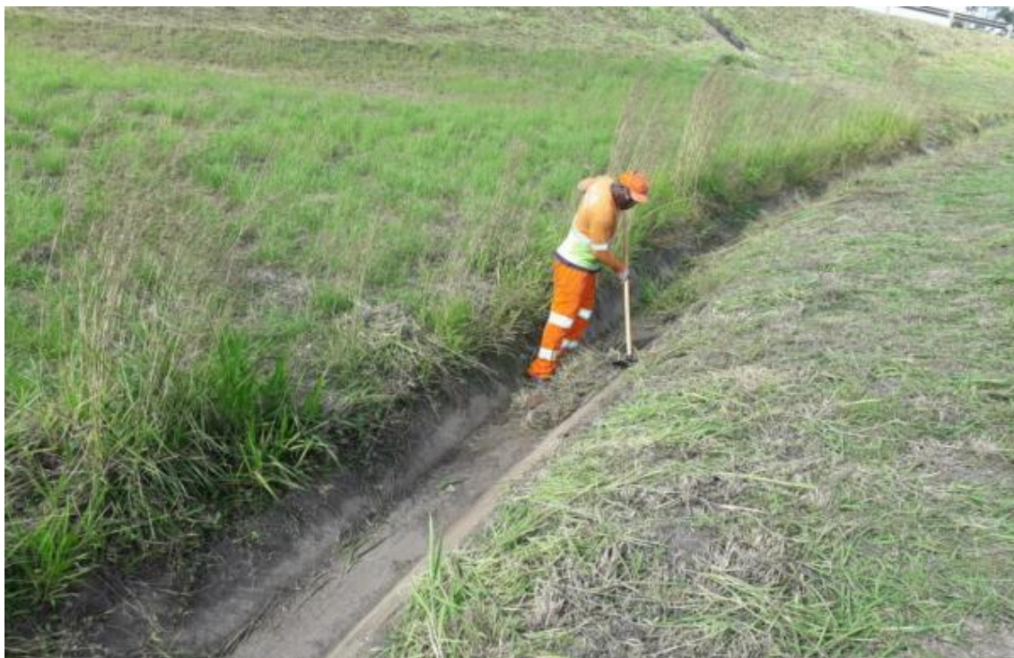
Figura 6.6 Via Lagos – Limpeza de canaleta – Km 56+800 Norte
