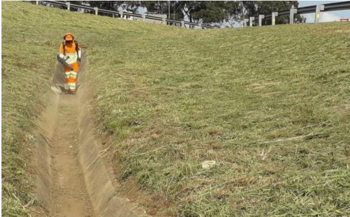
Figura 6.7 Via Lagos – Roçada manual – Km 56+800 Norte
