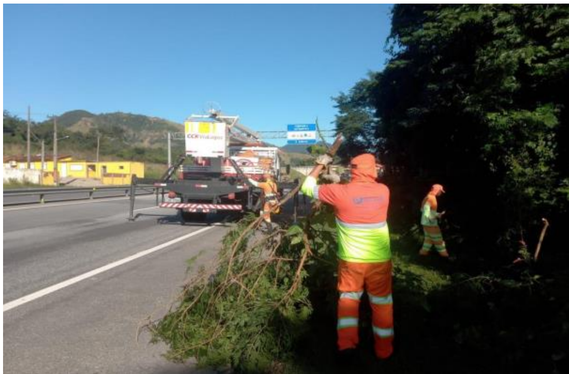
Figura 6.12 Via Lagos – Poda de árvores– Km 22+100 Sul
